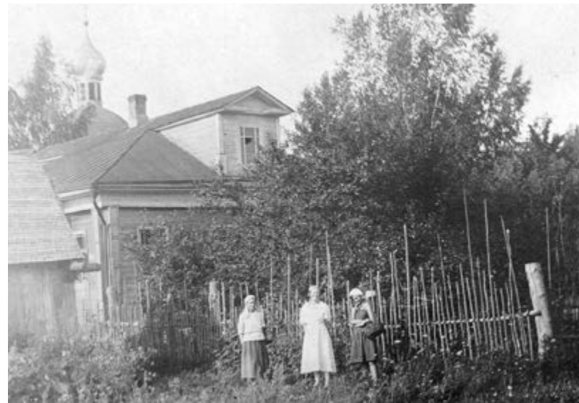
Здание Николо-Дорской начальной школы. Фото 2-й пол. 1930-х гг.
